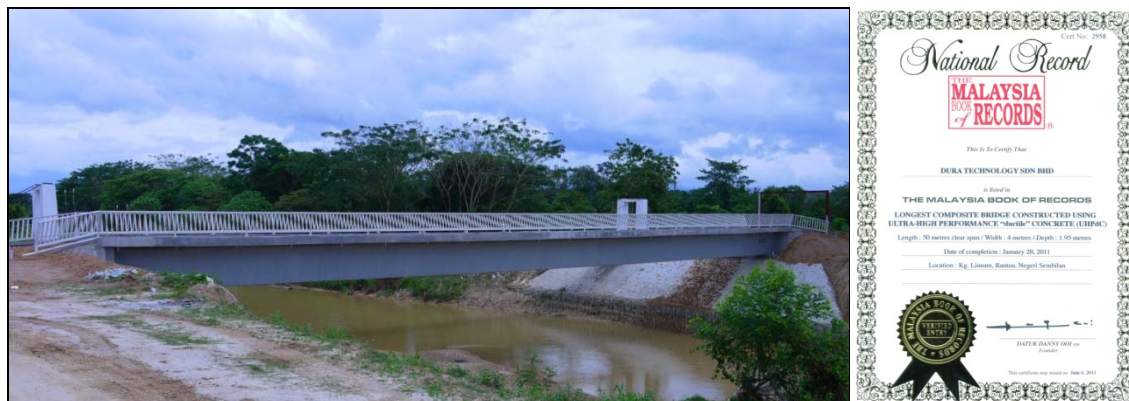
Figure 20: Kampung Linsum Bridge, Rantau, Negeri Sembilan.
