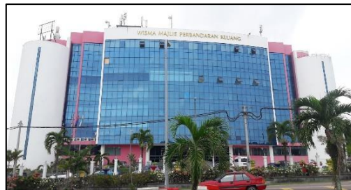
Rajah 1: Gambar Bangunan Wisma MPK (Portal Rasmi MPK, 2021)
